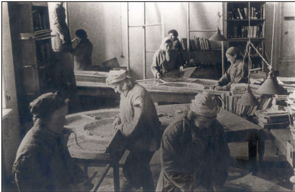
Восстановление здания института силами сотрудников — остекление окон в библиотеке
