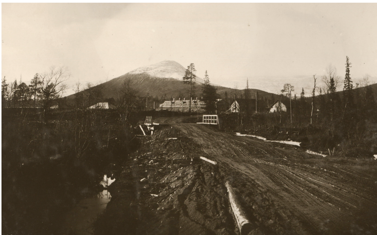
Рис. 4. Строительство дороги и поселка у подножья горы Ниттис. Фото 1930-х годов. Архив Музея истории Мончегорска
