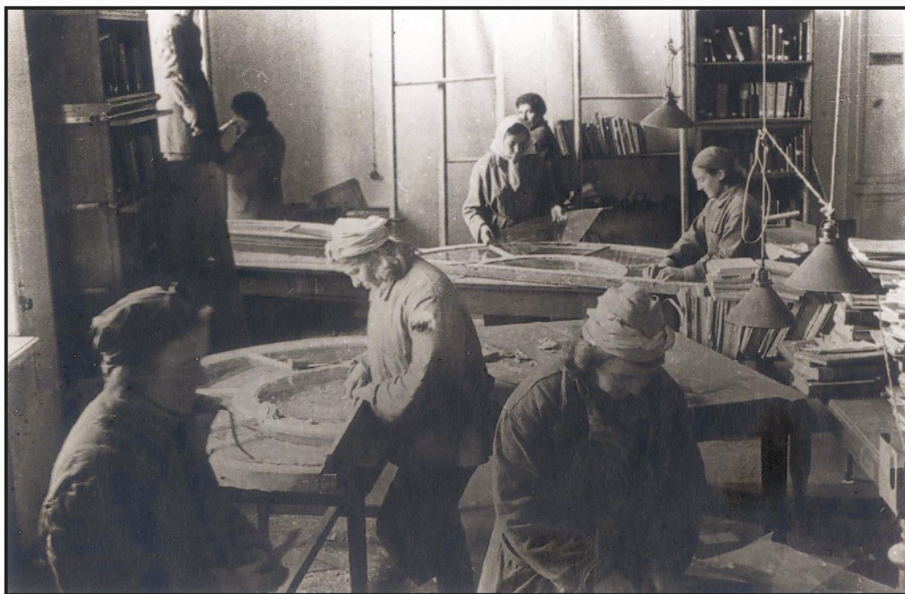
Восстановление здания института силами со- трудников — остекление окон в библиотеке
